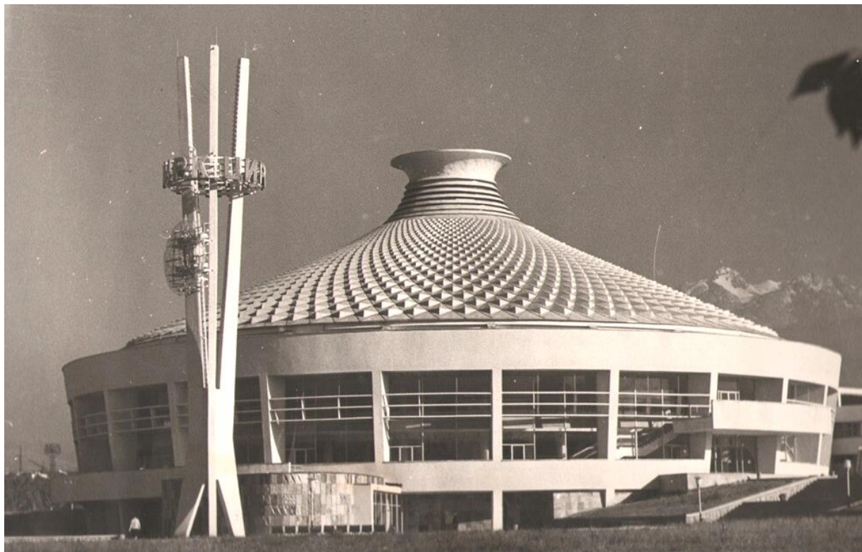
Рис. 8. Здание Казгосцирка в г. Алматы.
