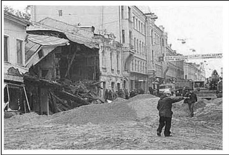
*Рис. 3. Разрушенный в ходе прокладки коллекторного тоннеля дом на ул. Большая Дмитровка, г. Москва [12]*
