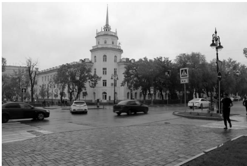
Рис. 3: Здание Казпотребсоюза, г. Алматы, площадь Астана (арх. Стесин Б.Н., Бобович Г., Беккер М., инженер Лухтанов В.)
