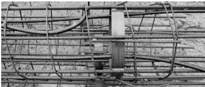
Рисунок 1. Арматурный каркас с циркуляционными контурами
